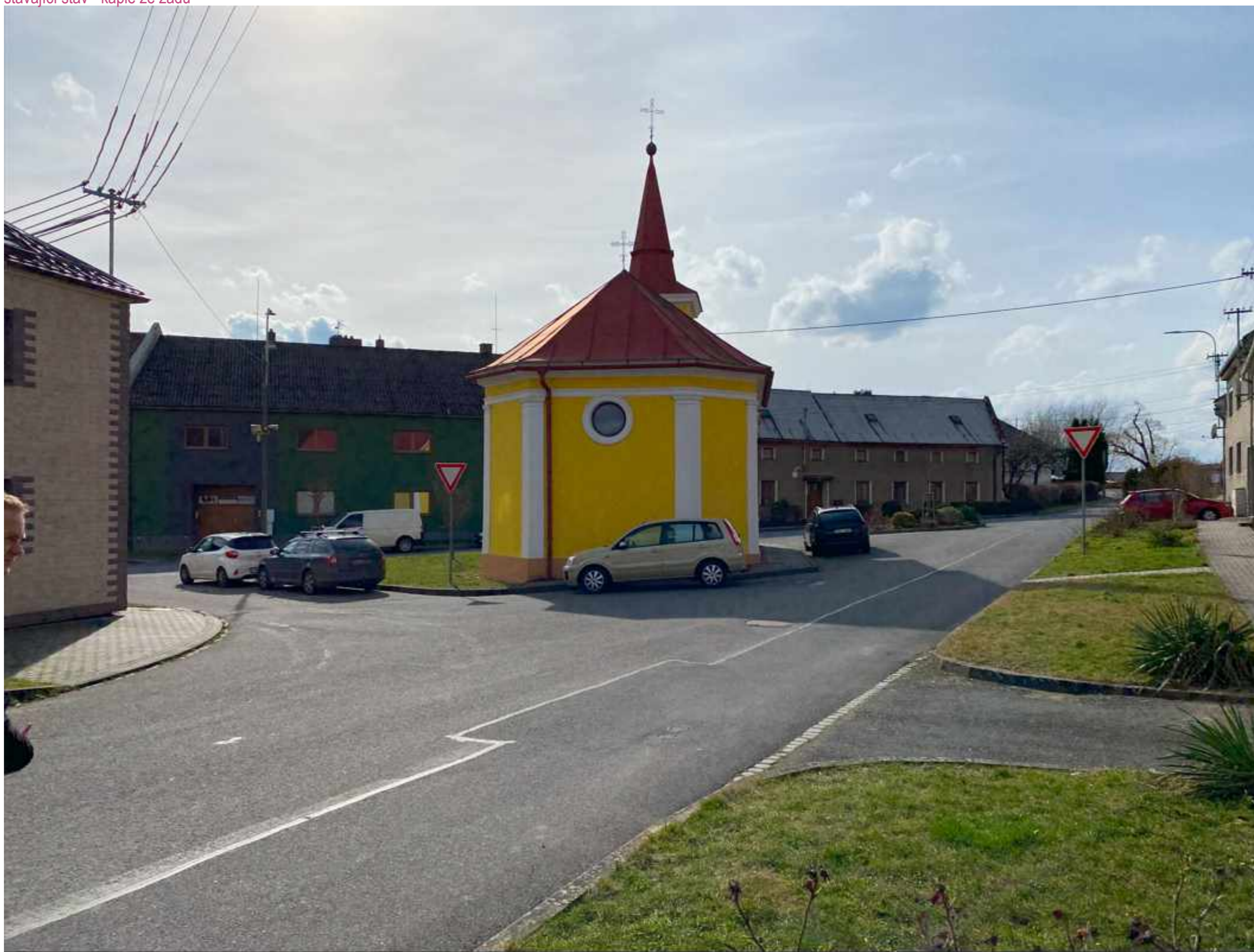
stávající stav - kaple ze zadu
